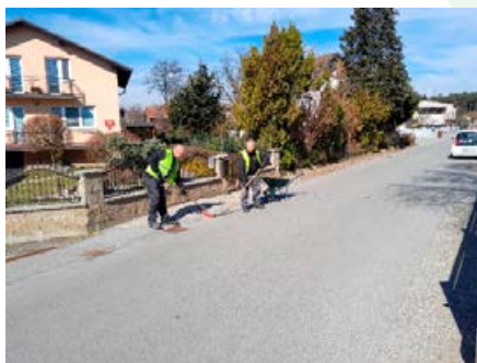
Montaža prometnega znaka
