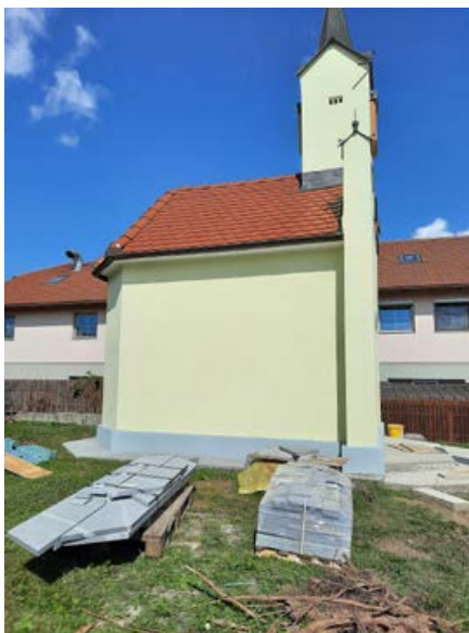
Kapelica pred obnovo in po njej
